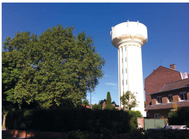
Approvisionnement en eau à Arras
