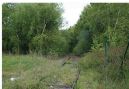
voie ferrée interne au site
