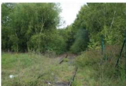
voie ferrée interne au site
