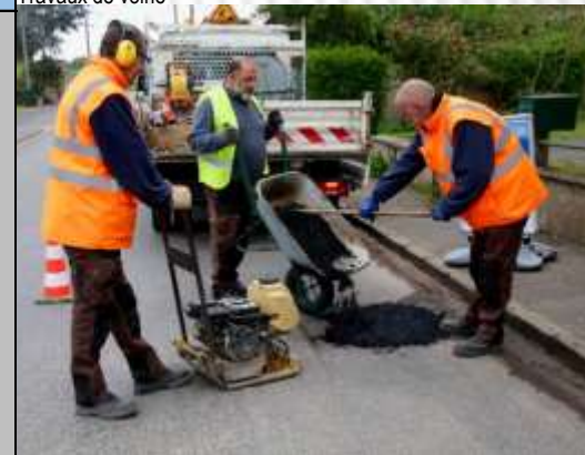
Travaux de voirie
