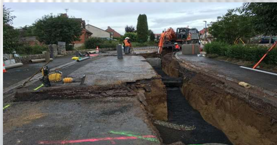
Travaux de réseau Maroeuil
