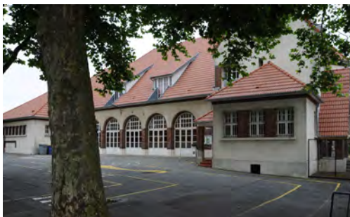
Bâtiment de l'école avec préau intégré et arcades arrondies basse pour une adaptation à la taille des écoliers.
