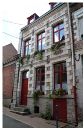
Immeuble à 3 trames sur cave de stockage à accès direct sur la rue.
