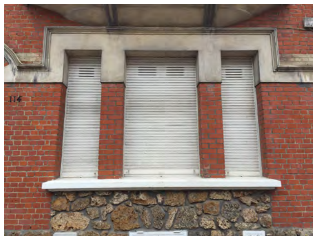
Maçonnerie mixte : soubassement en pierre meulière, façade de brique, modénatures de béton.
