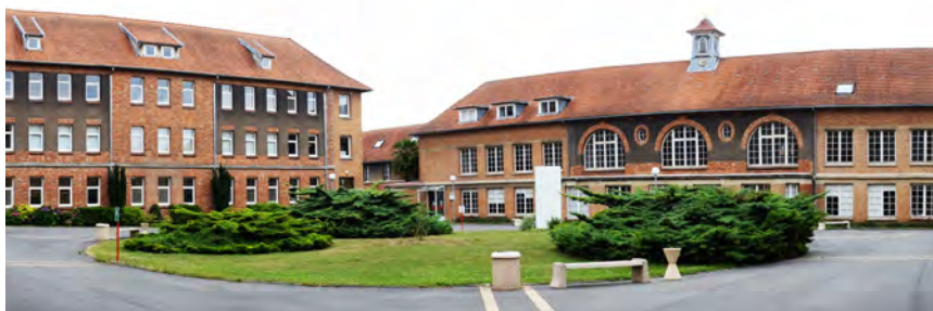
Composition symétrique de bâtiments organisés autour d'une cour centrale constituant le cœur de l'Université d'Artois. Cet ensemble monumental occupe une ancienne école d'infirmières.
