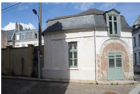
bâtiment de service en angle constituant un logement annexe ou complémentaire.
