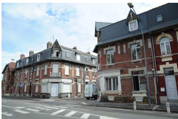
Importante composition urbaine d'un ensemble de maisons de ville conçu comme un « collectif à l'horizontale », s'enchaînant sous une toiture filante commune, commerces sur l'angle de rues et cours-jardins en cœur d'îlot.
