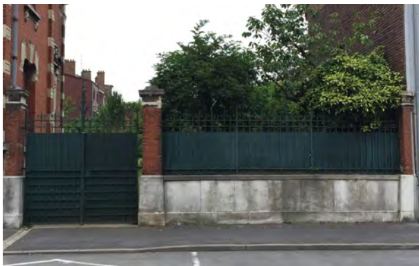
Clôture de jardin : mur bahut, piles en briques, portail et grille en ferronnerie, assortis.
