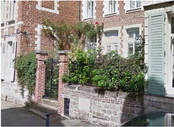
Clôture de jardinet avant : muret pierre et brique, couronnement grès, surmonté de grille, fermant le jardinet; portail entre piles de brique.
