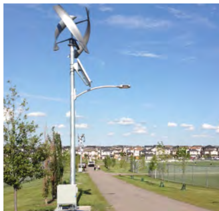
Eolienne à axe vertical, couplée à un panneau photovoltaïque pour l'éclairage public.
