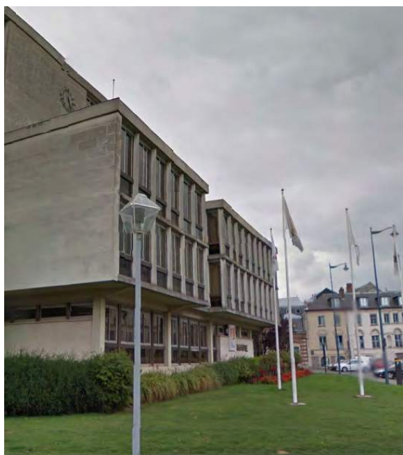
Abords de l'hôtel de ville, espace vert ouvert sur la ville
