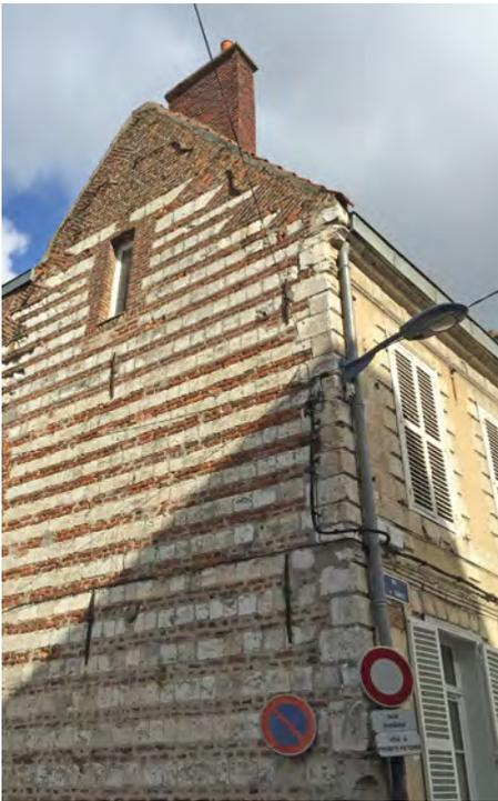
*Pignon alternant les lits de calcaire et de brique, pour une façade principale en brique enduite avec modénatures en pierre de taille.*
