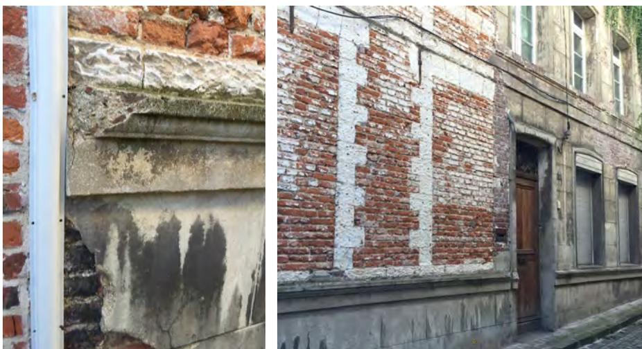
*Maçonnerie de brique enduite (avec cadres de baies en pierre) dont le revêtement a été retiré : la paroi piquée pour l'accroche de l'enduit devra être ré-enduite, avec l'enduit plâtre à modénatures encore visible sur une partie de la façade. Le ciment sur le soubassement doit être déposé et remplacé par un enduit perméable laissant passer la vapeur d'eau pour éviter que l'humidité ne s'évacue par l'intérieur du bâtiment et dégrade les parois.*
