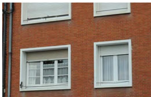
Les fenêtres Art déco et Mouvement étaient souvent conçues avec des volets roulants intégrés, ou sans volets.
