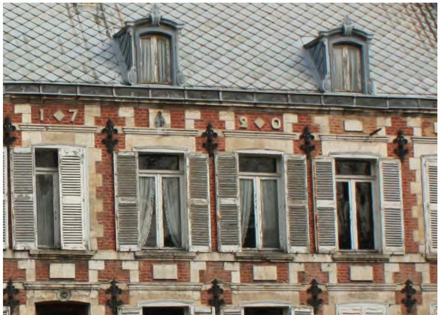
Sauf la date de construction en chiffres de pierre, 1720, et l'alternance de matériau des allèges, le décor est en lien avec la structure et la composition du bâtiment : clés de tirants, encadrements de baies, piedroits et clés de voûte des lucarnes en zinc.
