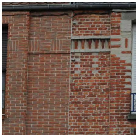
*La brique a parfois été entièrement recouverte de plaquettes, lui faisant perdre toutes ses qualités. Lorsque la construction fait partie d'un ensemble de conception homogène, celui-ci est également altéré.*
