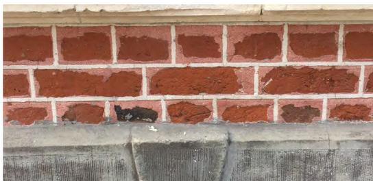
Briques endommagées par un rejointoiment inapproprié : les joints de brique, trop élargis par le dégarnissage de l'ancien mortier de jointoiment, ont été bourrés avec un mortier coloré, puis la ligne blanche a été ajoutée pour recréer visuellement un joint d'épaisseur normale.
