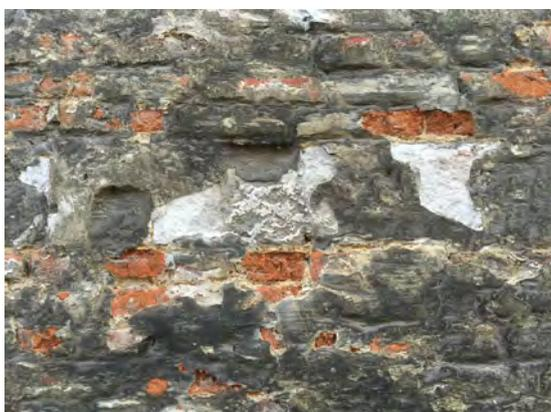
*A une certaine époque cette maçonnerie de lits de calcaire et de lits de brique alternés a été recouverte d'un enduit trop étanche derrière lequel les matériaux ont été dégradés par l'humidité enfermée.*
