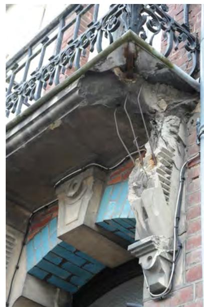
*Balcon et console en béton ont éclaté sous l'effet de la rouille qui a attaqué le montant du garde-corps.*
