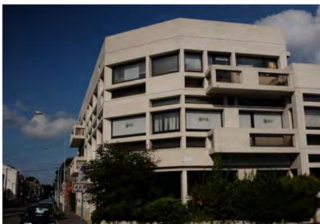
Version années 1970 du collectif basée sur une façade en béton porteuse et trame dans laquelle prennent place les ouvertures et balcons.
