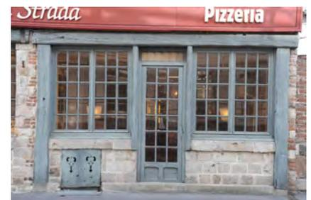
Linteau filant permettant une implantation libre des percements pour l'installation d'un commerce.
