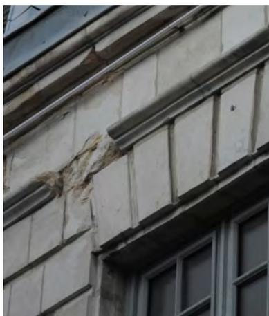
*Un bandeau endommagé laisse le ruissellement d'eau pénétrer la façade et dégrader le parement. Une réparation de la pierre doit être effectuée pour restaurer la protection.*
