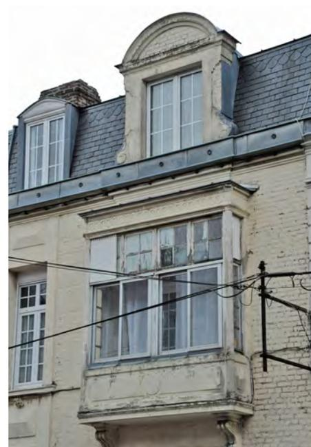
Certains oriels ont subi des modifications inappropriées : remplacement de la structure bois par du béton, des fenêtres bois par du pvc ou de l'aluminium. Ces défauts sont réversibles : l'oriel reconstitué peut revaloriser la construction.
