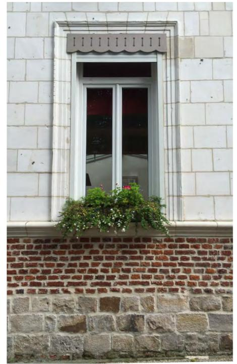
*Façade de pierre calcaire sur soubassement en pierre dure et brique.*
