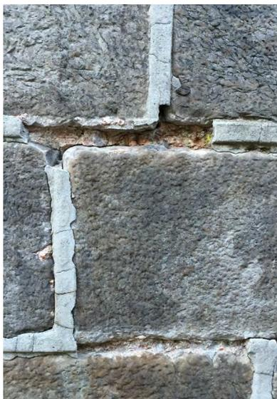
*Un joint inapproprié, trop étanche, enferme l'humidité et finit par se dégrader.*
