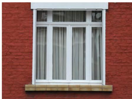
*Appui de fenêtre recouvert de plaquettes, d'autant plus regrettable sous une menuiserie en bois d'origine, finement moulurée.*
