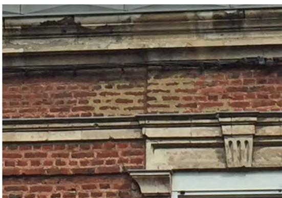
*Entre la corniche et le bandeau en pierre : réparation de la brique avec un mortier inapproprié.*
