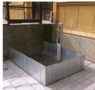
Plate forme élévatrice encastrée dans le sol (hauteur de 60 à 90 cm)
