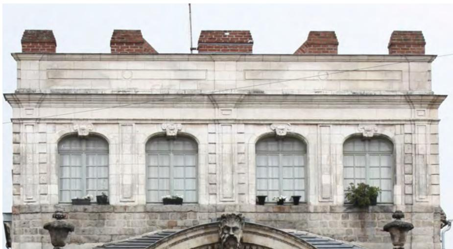
Composition symétrique rigoureuse soulignée de bandeaux et corniches, de pilastres et trumeaux moulurés et de sculptures sur les clés de voute.
