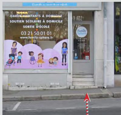
Différence de niveaux importante : la solution technique ne peut être que mécanique
