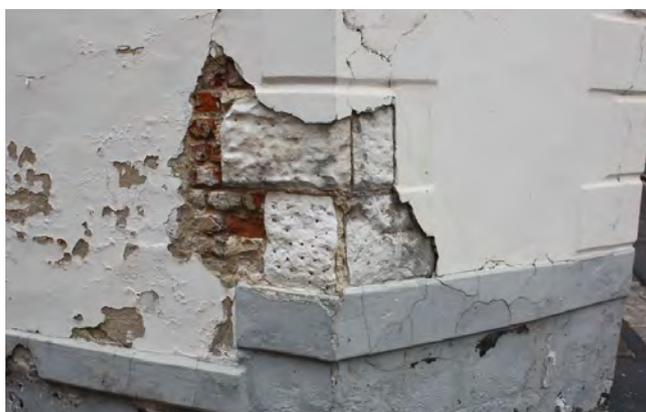
*Maçonnerie de brique à chaînage de pierre revêtue d'un enduit inadapté.*
