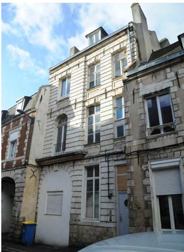
L'ouverture du porche de cet immeuble XVIIIème a été comblée pour exploiter le volume bâti situé derrière, et mal réalisée (maçonnerie de parpaings enduite, suppression de l'épaisseur de la baie).
