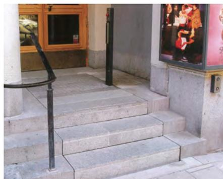
Plate forme élévatrice intégrée : les marches se transforment en plate forme
