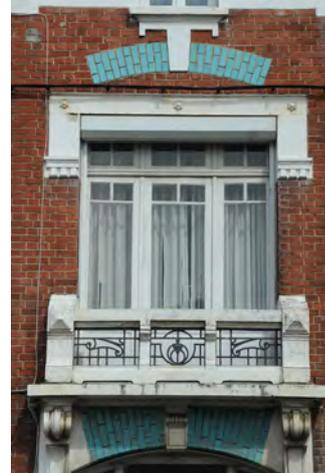
Deux vantaux non divisés ou divisés en carreaux plus hauts que larges, une traverse moulurée et une imposte généralement divisée en deux.
