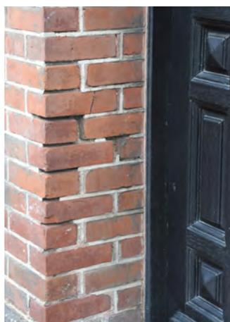
La disparition du joint fragilise la brique qui s'épauffe et se brise, en particulier dans les angles. Elle laisse l'eau imprégner la brique qui devient sensible au gel.
