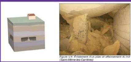
Figure V.6: Effondrement d'un pilier et affaissement du toit (Saint-Même-les-Carrées)
