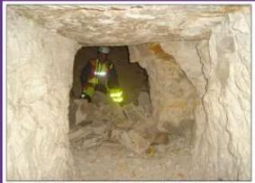
Figure V.3: Effondrement du toit (rue des Hochettes - Arras)
