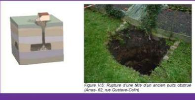
Figure V.5: Rupture d'une tête de puits (avenue 62, rue Gustave-Collin)
