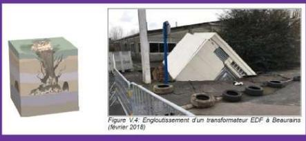
Figure V.4: Engouffrement d'un transformateur EDF à Beaurains (Nivier 2018)
