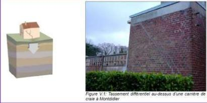
Figure V.1: Tassement différentiel au-dessus d'une cavité de craie à Montdidier
