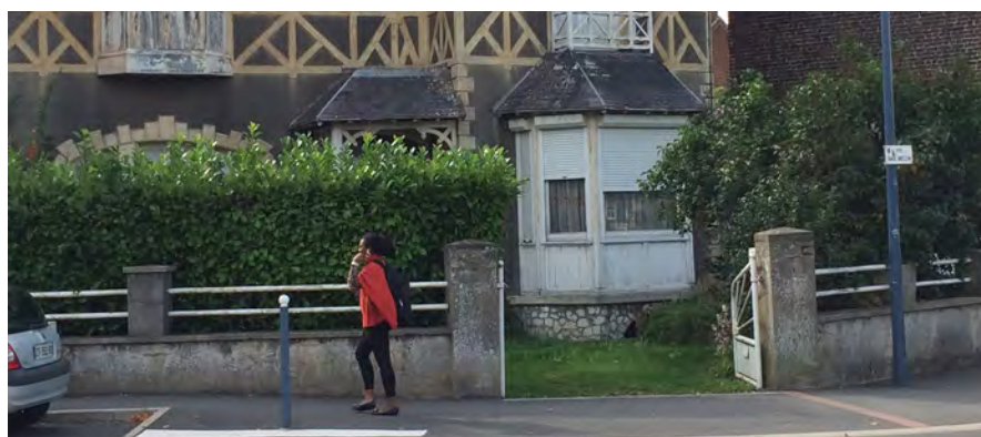
La clôture à barreaudage horizontal tubulaire sur soubassement maçonné, et le portail sont typiques des années 60.
