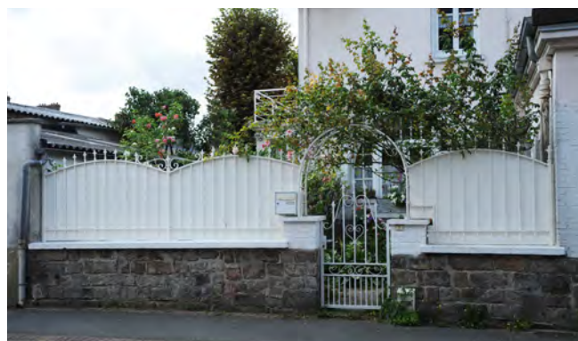
Clôture de jardin : mur bahut en grès, grille en ferronnerie doublée d'une tôle pleine, et portail ajouré assorti.
