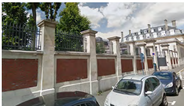
Clôture de jardin privé : soubassement et chaînage pierre, surmonté d'une grille entre piles en pierre de taille avec couronnements moulurés.
