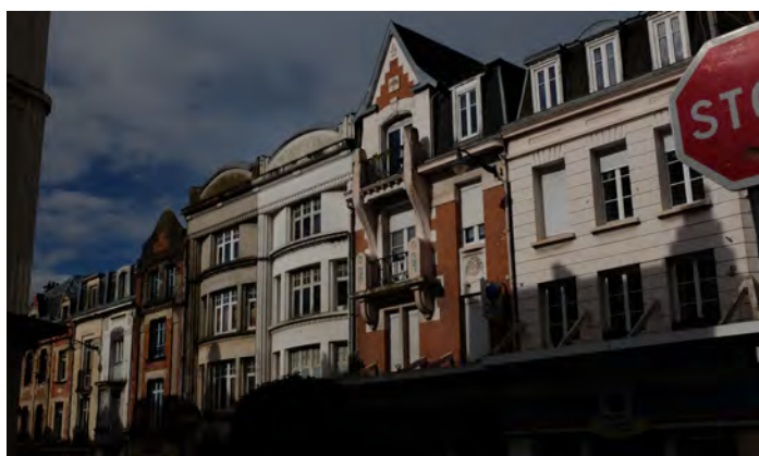
Juxtaposition d'immeubles construits à la même époque et avec le même esprit de démonstration joyeuse : bâtiments jumeaux à orielles courbes et composition traditionnelle mais avec balcons typés Art déco.
