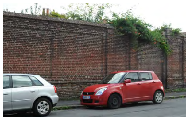
Murs de briques rythmés de panneaux.
