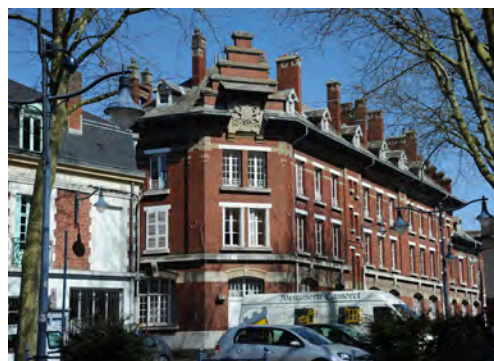
Ecole Anatole France : angle marqué par une évocation de pignon à pas de moineaux, orné d'un important haut-relief en pierre.
