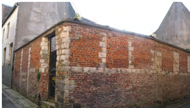
Murs de briques avec chaînages de calcaire.
