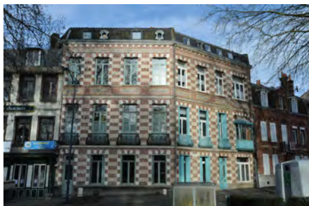
Collectif d'angle : exemple rare d'un bâtiment de logements conçu au début du XX ème siècle sans référence aux habitats traditionnels.
