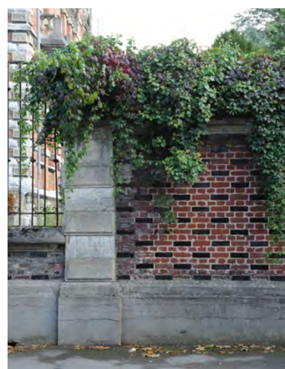
Mur de brique à motif bicolore, alternant avec une grille en ferronnerie ; soubassement, dessus de mur et piles avec modénatures.
