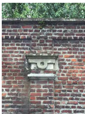
Pilastre souligné d'une moulure et d'un chapiteau en calcaire.
