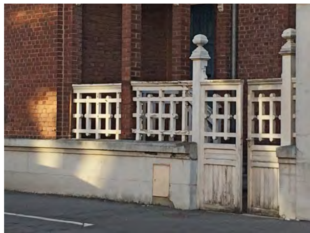
Maçonnerie de brique bicolore avec effet de claire-voie dans le couronnement.
