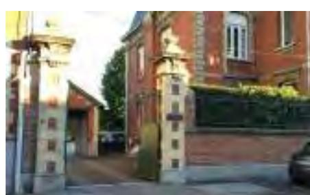
Murs et grilles, soubassement béton, brique, pierre ou béton en couronnement, grille travaillée, parfois occultation métallique / végétale
