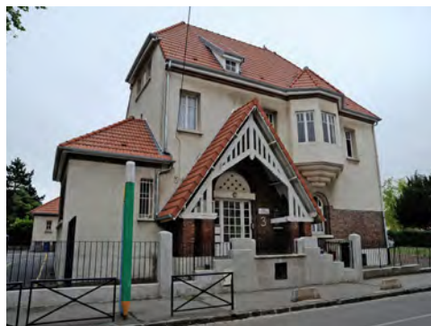
Bâtiment administratif et logement du directeur de l'école; l'entrée à auvent triangulaire crée un accent formel à cette architecture domestique en multiples volumes.
