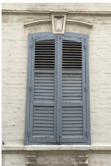
Un cadre de bois recevant les volets bois persiennés, installé dans une maçonnerie de brique Eclectique.
