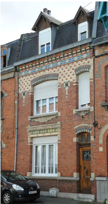
Décor complexe de briques de trois couleurs, frises et cabochons de céramiques, associés à un léger relief et complété par
