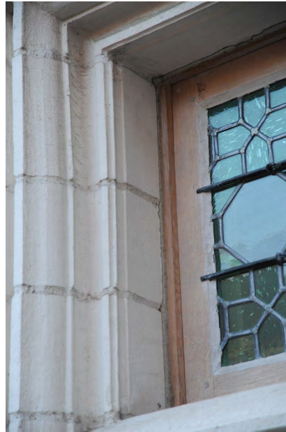
Détail du cadre de fenêtre mouluré en pierre, appelé chambranle, du refuge de l'Abbaye d'Etrun, inscrit au titre des Monuments historiques.
