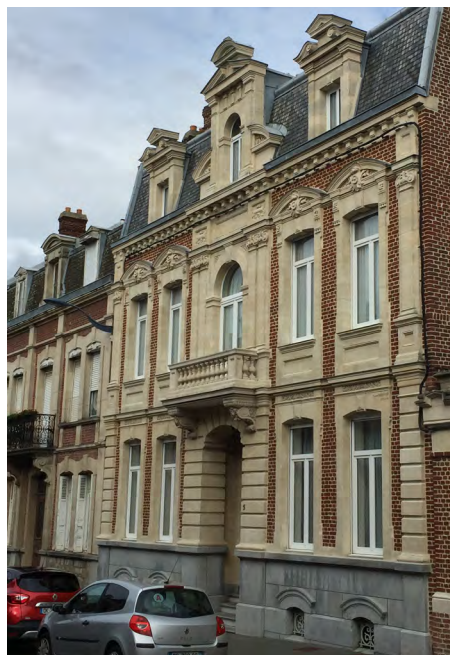
Pierre dominante et brique avec soubassement en pierre bleue. La pierre de taille majoritaire sur la façade principale souligne une composition forte par des éléments architectoniques de style Classique, utilisés à la période Eclectique.
