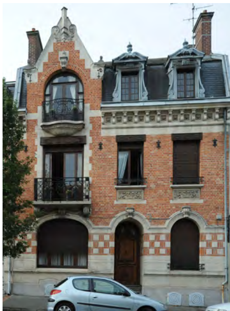
Brique dominante ; la pierre est utilisée pour former un riche décor, caractéristique du style Eclectique : linteaux, appuis, balcons, couronnements.
