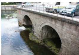
ouvrages d'art (busage)
