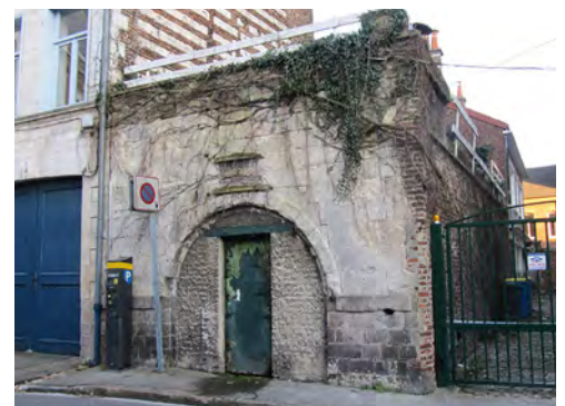
Accès au réseau de carrières rue du Saumon.
