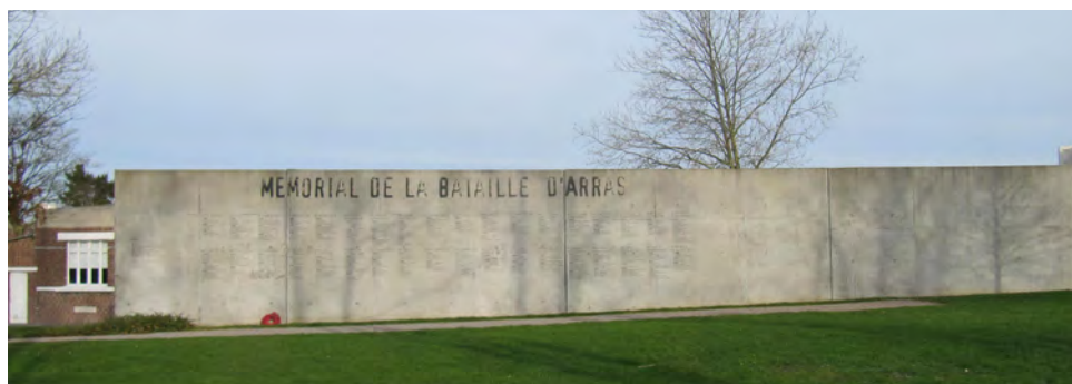
Carrière Wellington, rue Delétoille Mémorial de la bataille d'Arras
