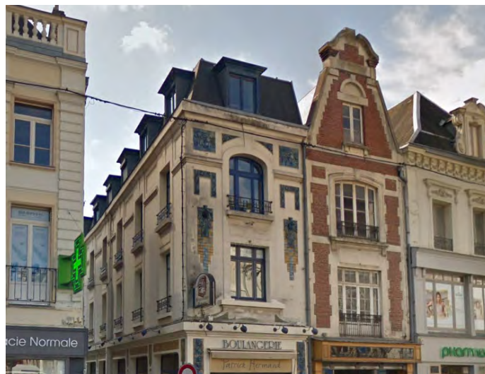
Deux immeubles reconstruits sur la trame parcellaire conservée :
