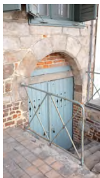
Accès aux caves de la Grand Place
