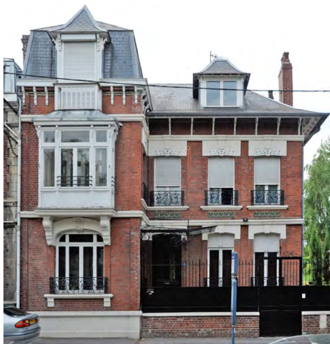
Le toit de l'oriel sert d'appui à un balcon pour une grande lucarne passante, configuration fréquente.
