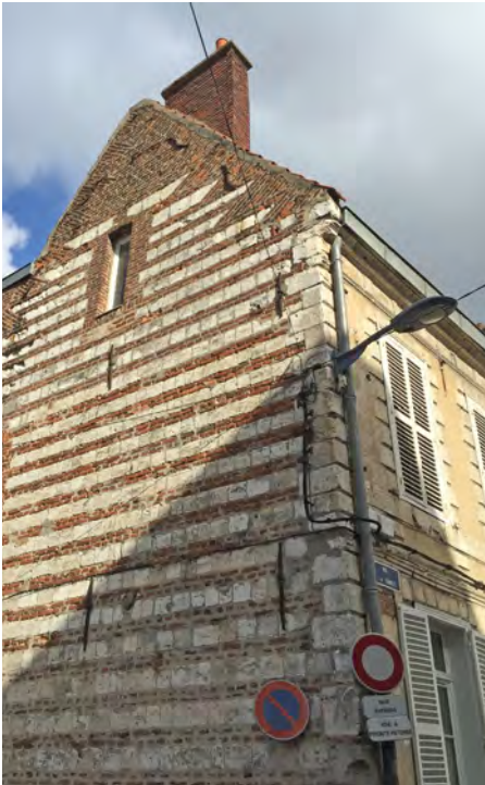
Pignon alternant les lits de calcaire et de brique, pour une façade principale en brique enduite avec modénatures en pierre de taille.
