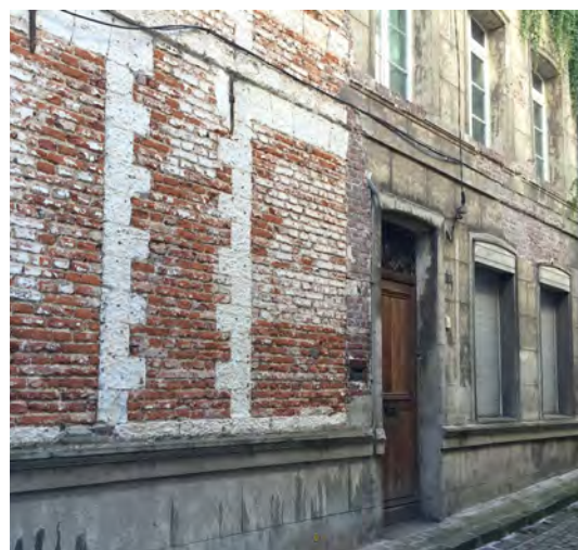
Maçonnerie de brique enduite (avec cadres de baies en pierre) dont le revêtement a été retiré : la paroi piquée pour l'accroche de l'enduit devra être ré-enduite, avec l'enduit plâtre à modénatures encore visible sur une partie de la façade. Le ciment sur le soubassement doit être déposé et remplacé par un enduit perméable laissant passer la vapeur d'eau pour éviter que l'humidité ne s'évacue par l'intérieur du bâtiment et dégrade les parois.
