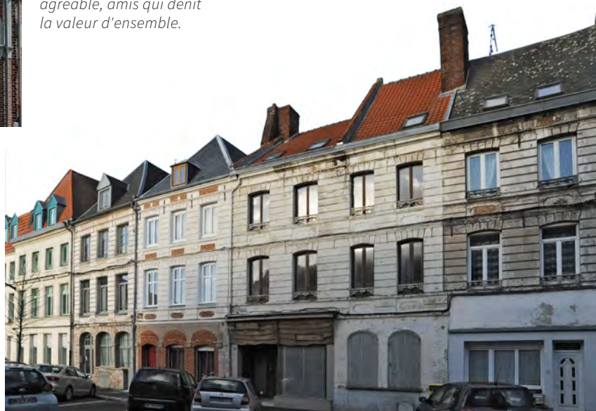
Cet ensemble de maisons de ville Classique a subi de nombreuses altérations qui en diminuent la force. Les modifications des rez-de-chaussée sont les plus dommageables, tant pour les constructions qui les ont subies que pour l'ensemble.
