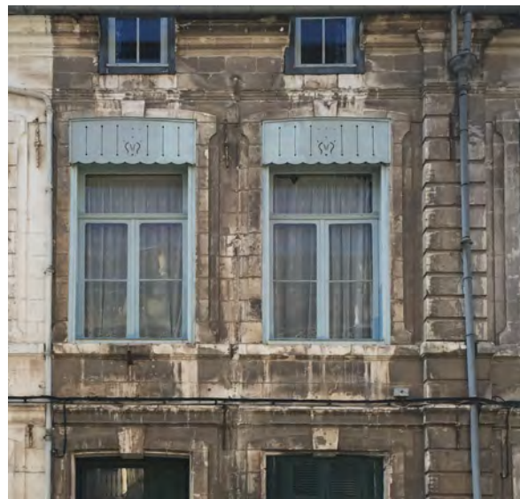
Façade de pierre à nettoyer : une technique non agressive est indispensable pour ne pas endommager le parement.
