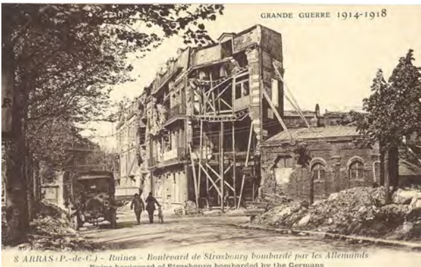
Immeubles endommagés Bld de Strasbourg
