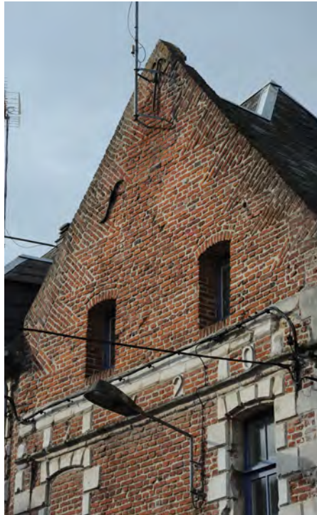
Pignon de brique avec modénatures de pierre.
