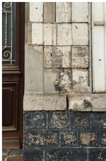
Réparation de pierre calcaire avec du au ciment, recouvrement du soubassement en grès.
