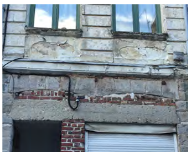
Linteaux en grès, restes d'arcades en grès supprimées, à recréer.
