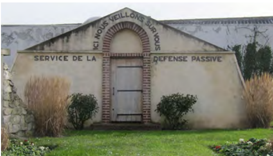
Porte d'entrée aux souterrains abris de la défense passive, rue de Bapaume.
