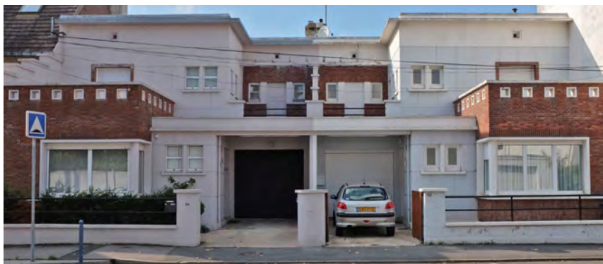
Dans cette architecture moderniste, la brique est utilisée pour souligner le jeu des volumes et détacher les « cubes » en béton.
