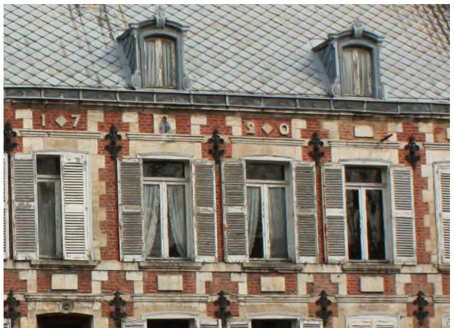
Sauf la date de construction en chiffres de pierre, 1720, et l'alternance de matériau des allèges, le décor est en lien avec la structure et la composition du bâtiment : clés de tirants, encadrements de baies, piedroits et clés de voûte des lucarnes en zinc.
