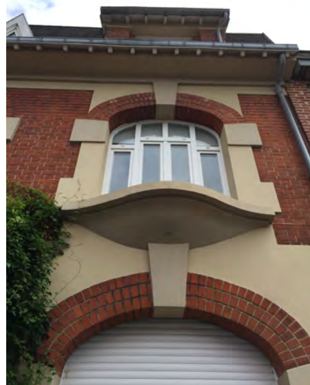
Brique et béton dans le style Art déco.
