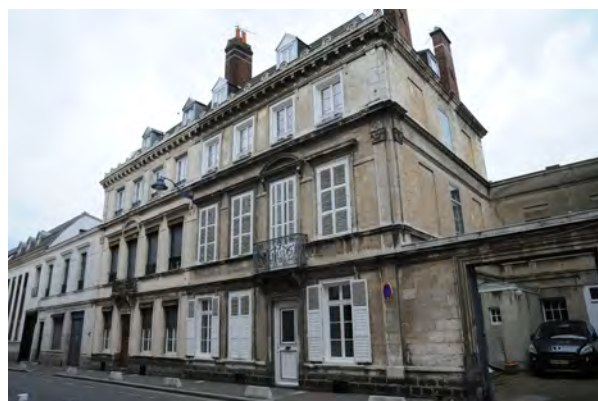
Hôtel particulier de style néo-Classique : implanté à l'alignement et sur une parcelle peu profonde ; la cour est reportée sur le côté, fermée par un mur continuant la façade et un portail.
