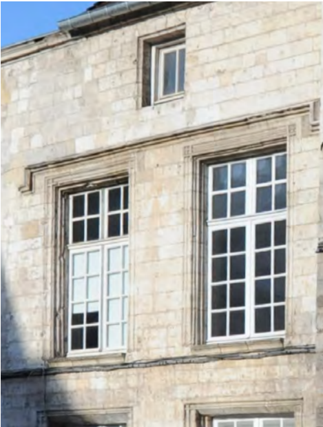
Chambranle surmonté d'un larmier en saillie. Maison canoniale XIII ème -XIV ème , n°14 place Jean-Moulin, classée Monument historique.
