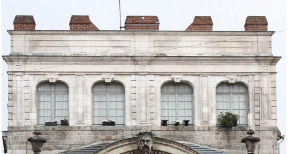
Composition symétrique rigoureuse soulignée de bandeaux et corniches, de pilastres et trumeaux moulurés et de sculptures sur les clés de voûte.
