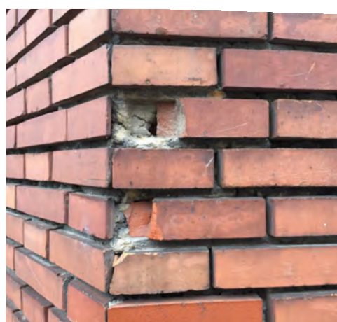
La construction en brique du milieu du XXème siècle a parfois utilisé le parement de brique non jointoyée pour son effet visuel «vif» ; ici taillées en biseau dans l'angle, le joint creux les rend plus fragiles.
