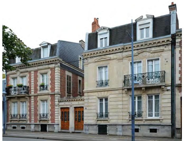
Maisons fausses jumelles : pour ces deux maisons composées sur un plan symétrique, avec des façades qui reprennent les mêmes règles, les coconstructeurs ont choisi des matériaux et des décors différents qui les distinguent nettement l'une de l'autre.
