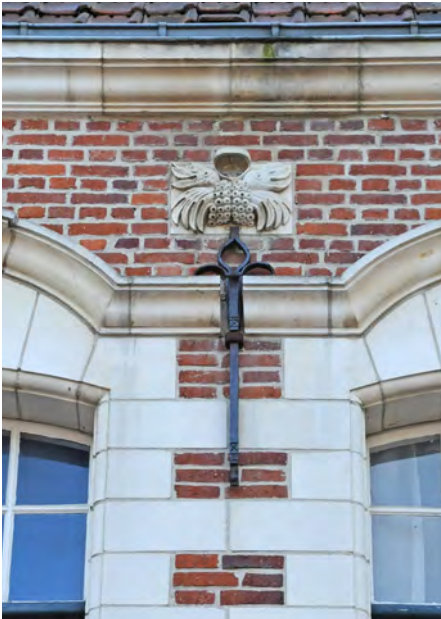
La position du médaillon sculpté est combinée avec celle du tirant métallique dans l'axe du trumeau.
