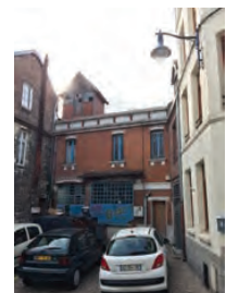
local artisanal rue de la Batterie
