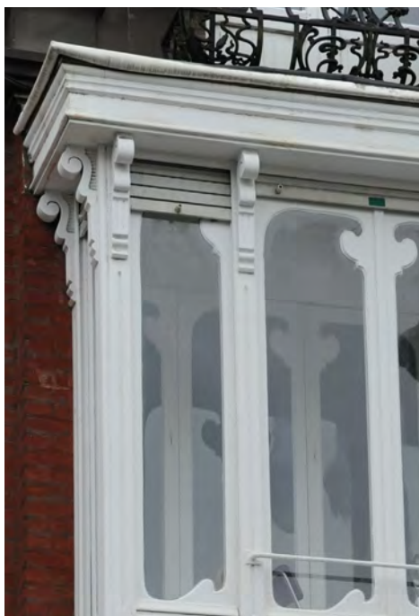
Un oriel de la période Eclectique équipé de volets roulants d'origine par vantaux.
