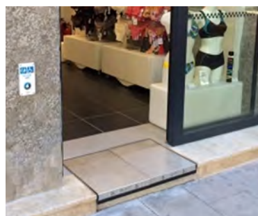
Rampe métallique encastrée dans le seuil, dépliant, avec boîtier d'appel pour la manoeuvre
