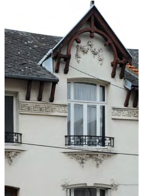
Charpente débordante, médaillon, frise, linteaux et appuis sculptés.
