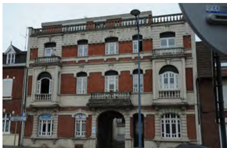
Ensemble organisé autour d'une cour comprenant des logements bourgeois dans la partie sur rue, et des logements plus modestes dans les ailes; locaux artisanaux en fond de parcelle.
