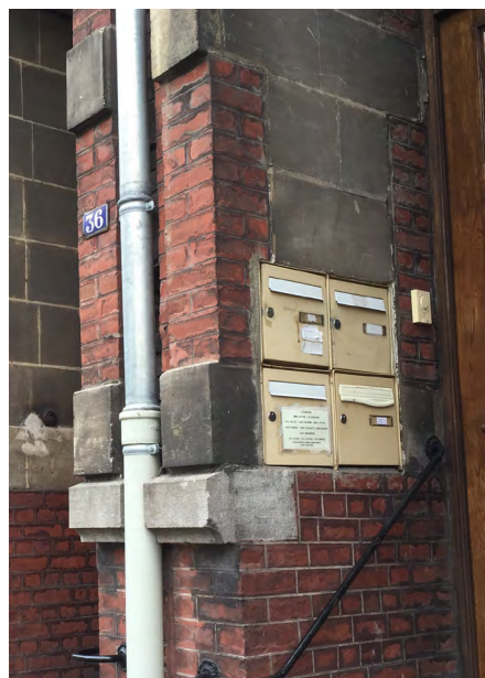
Les volumineuses boîtes aux lettres normalisées sont encastrées sur le côté de l'entrée, moins visibles depuis la rue.
