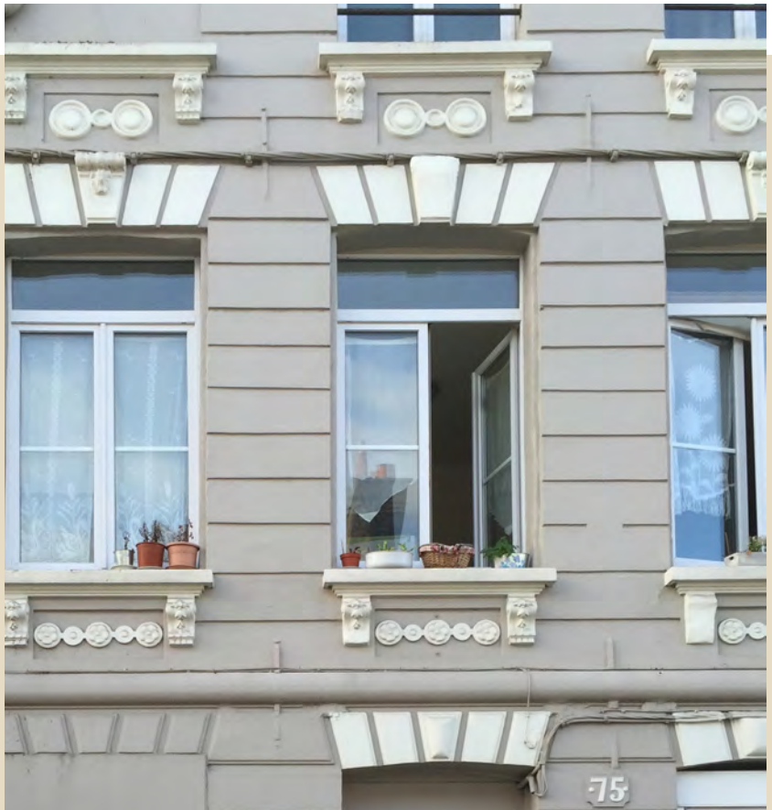
Reprise des appuis de fenêtres et décor de rosaces (+/- 1830-50), surlignés en blanc.
