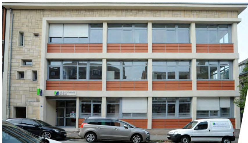
Une ré-interprétation contemporaine de l'emploi de la brique dans une maçonnerie mixte pierre + béton.
