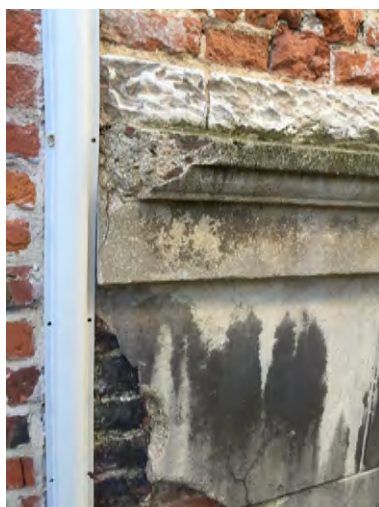
Maçonnerie de brique enduite (avec cadres de baies en pierre) dont le revêtement a été retiré : la paroi piquée pour l'accroche de l'enduit devra être ré-enduite, avec l'enduit plâtre à modénatures encore visible sur une partie de la façade. Le ciment sur le soubassement doit être déposé et remplacé par un enduit perméable laissant passer la vapeur d'eau pour éviter que l'humidité ne s'évacue par l'intérieur du bâtiment et dégrade les parois.
