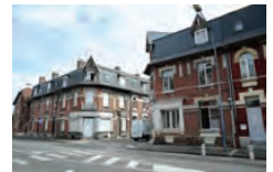
ensemble de logements + commerces rue des Augustines
