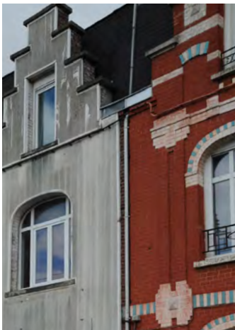
Deux maisons initialement jumelles, à décor en relief et en couleur, dont l'une a été entièrement revêtue de planches de PVC enduites. Cette disposition fait perdre toute qualité à la maison altérée, mais elle en fait également à sa jumelle.
