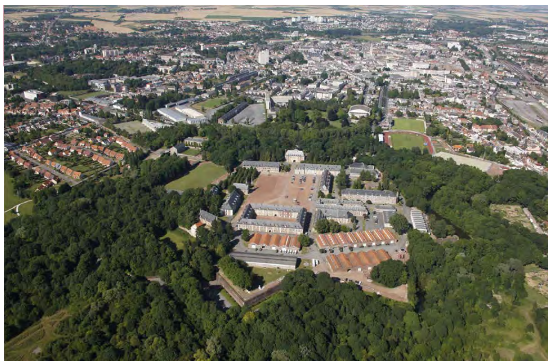
Vue aérienne de la citadelle en direction du centre ville.
