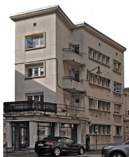
Reconstruction post Deuxième Guerre mondiale : immeuble du Mouvement moderne, rue St-Josse.
