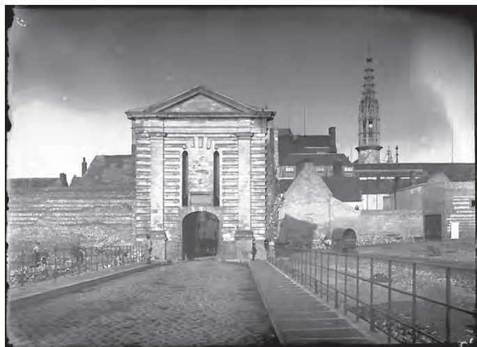
La porte d'Amiens au début du démantèlement des fortifications : l'enceinte démolie sur le côté droit de la porte.
