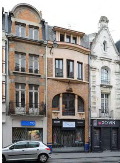
Reconstruction post Première Guerre mondiale : immeubles avec frontons dans le style Art déco, rue St-Aubert.
