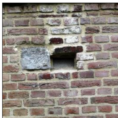
Photo 27. Exemple d'intégration de gîte à chauves-souris dans le bâti existant ( source : Ville de Lille)
