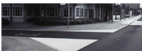
Dans ce contexte contraint, l'apaisement de la vitesse a été traité en amont du carrefour. La réduction de largeur de chaussée a permis de gérer le seuil d'un restaurant et l'attente du bus tout en proposant un cheminement confortable pour les scolaires.
