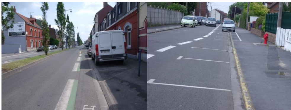
Exemples de dysfonctionnement deux roues : des itinéraires cyclables avec des emprises insuffisantes qui pénalisent la sécurité des deux-roues
