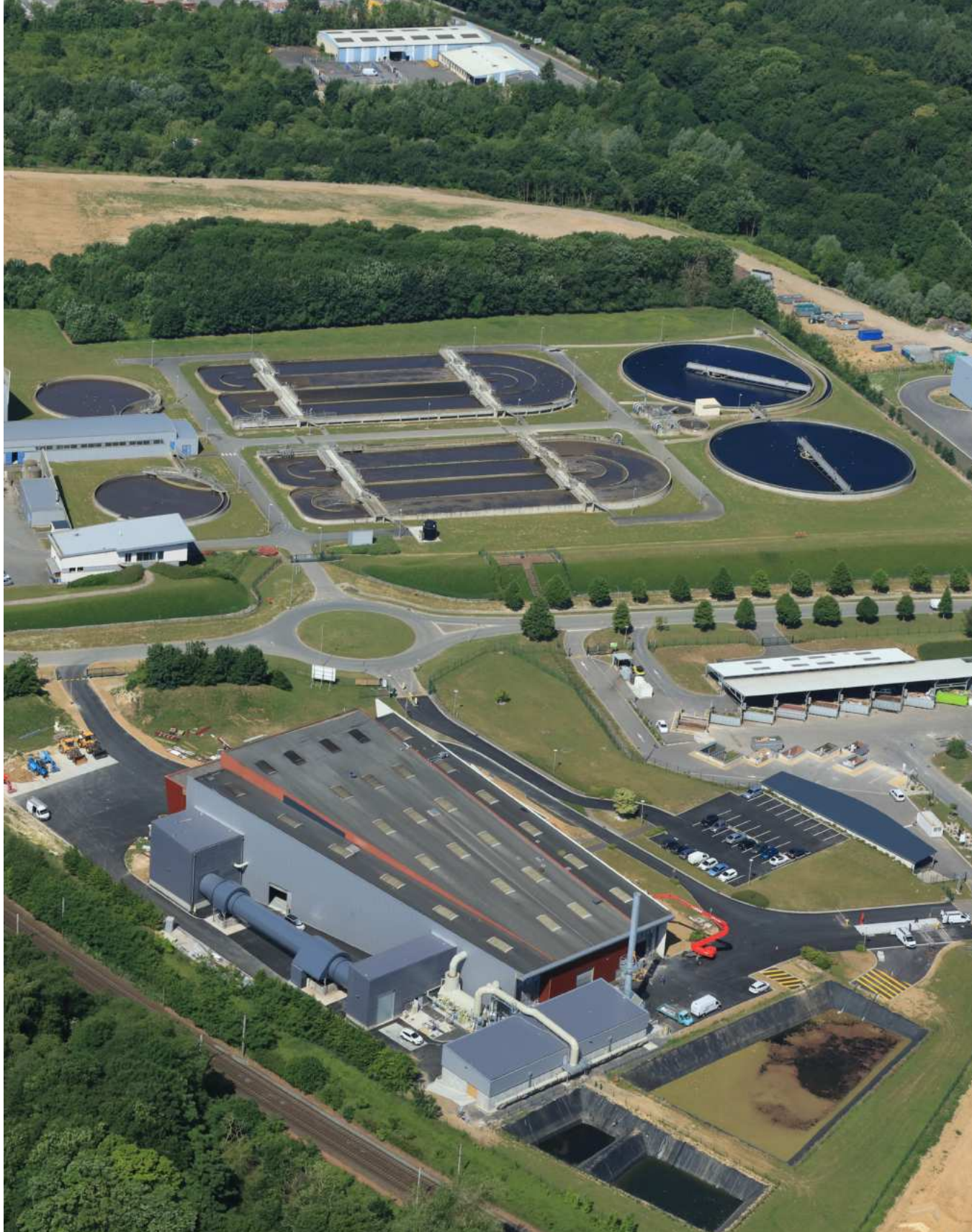
© Philippe Frutier - Altimage - Station d'épuration de Saint-Laurent-Blangy
