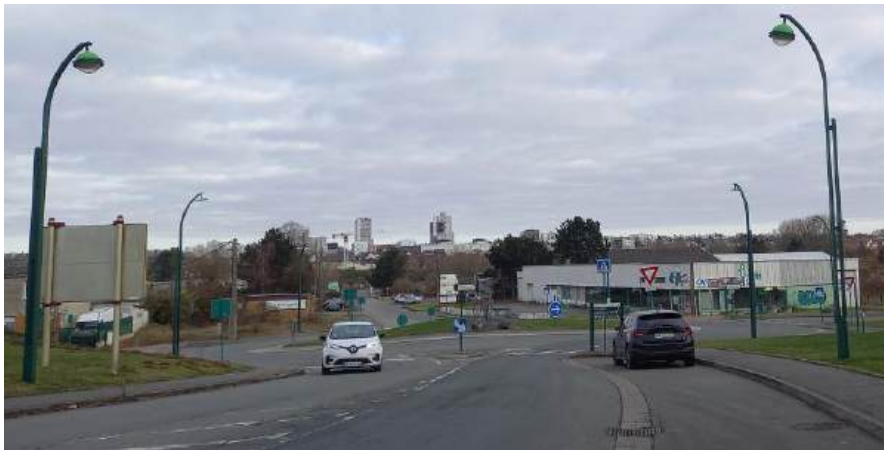
Figure 238 - L'éclairage public en entrée du parc d'activité - Photo : Ma-Geo - janvier 2024
