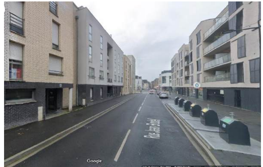
Figure 83 - Quartier multifonctionnel - Photo : Google Street view - aout 2023
