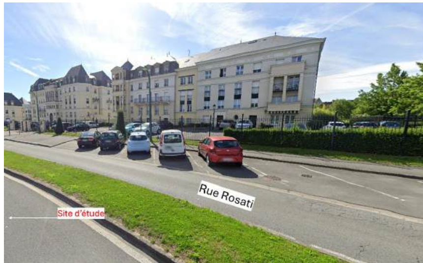
Figure 82 - Logements collectifs rue Rosati - Photo Ma-Geo avril 2024
