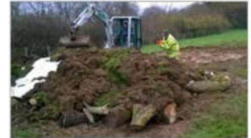
Figure 12. Tas de bois et de souches recouvert de terre végétale. Un géotextile perméable (facultatif) sépare la terre des rondins. (Source : www.conservationandaccess.co.uk )
