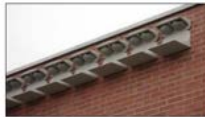
Photo 16. Planches antifientes installées sous les nids artificiels
