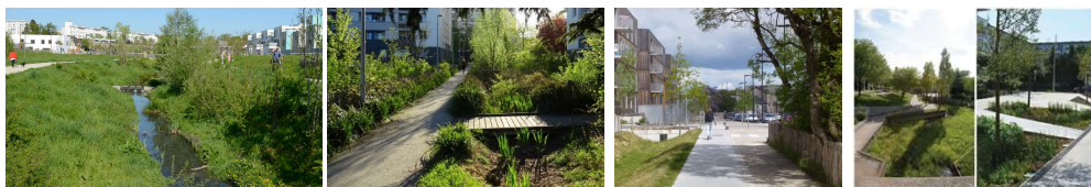
Gestion des eaux pluviales dans l'espace public – noues paysagères
